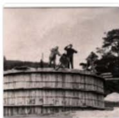
Výstavba vodovodu a vodojemov 32 položiek
